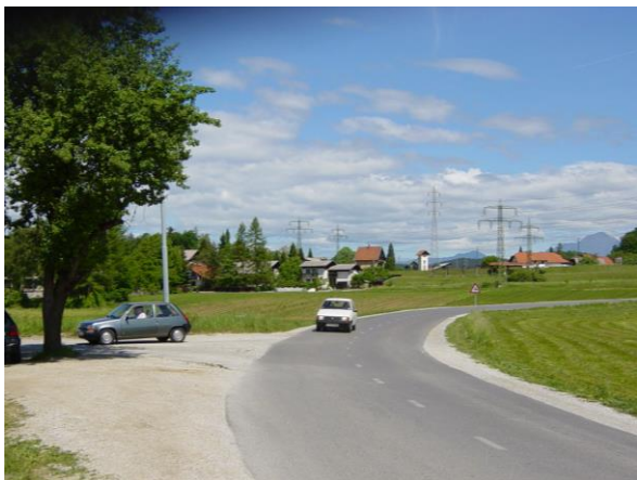
Postajališče in obračališče šolskega avtobusa.
