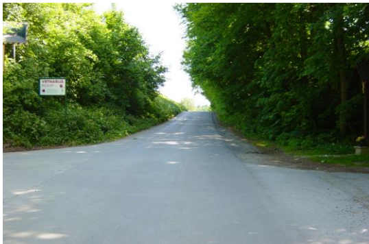
Cesta od Štefanca proti Lipi je brez pločnika in prehodov za pešce (l. 2017).
